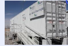
Spinning Reserve Systems Norgener 12MW - 15min Angamos 20MW - 15min Cochrane 20MW - 15min
